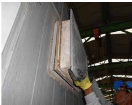
Fig. N° 1 Desinstalación de la tapa del vano
