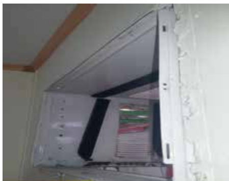
Fig. N° 2 Instalación de la carcasa del aire acondicionado
