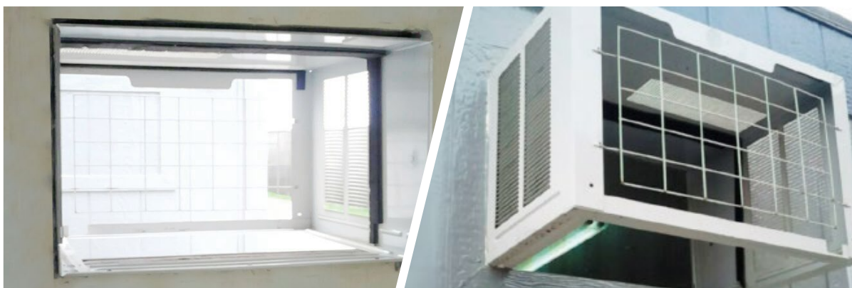
Fig. N° 2 Instalación de la carcasa del aire acondicionado
