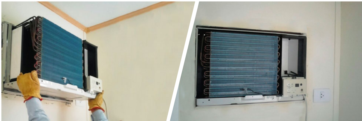
Fig. N° 3 Instalación del equipo
