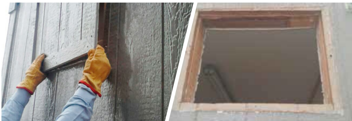
Fig. N° 1 Desinstalación de la tapa del vano
